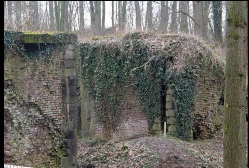
Rest van sluis
